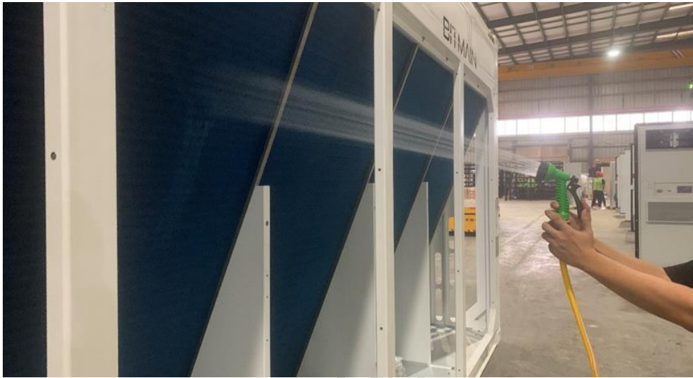
图 9.7 清洗换热器翅片示意图
