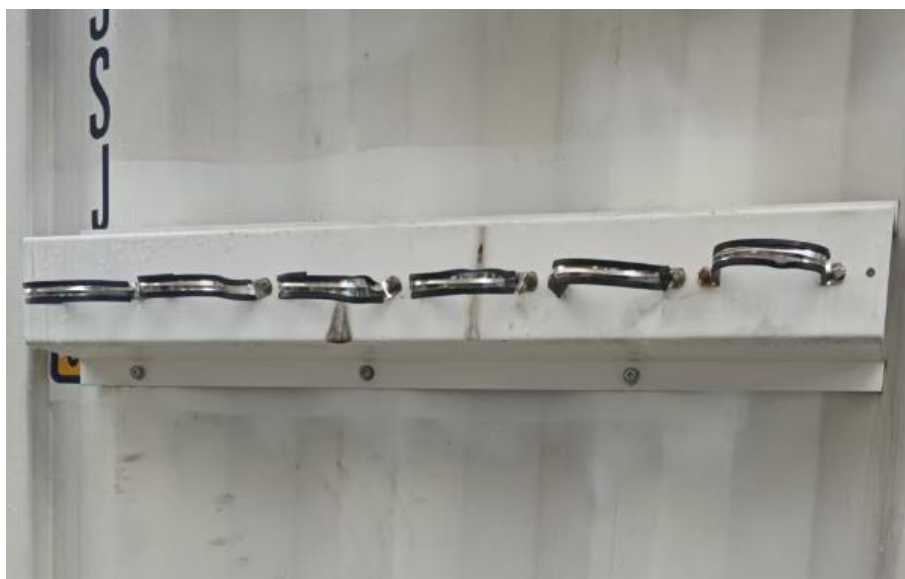
图 6.9 集装箱外部线缆固定架示意图
