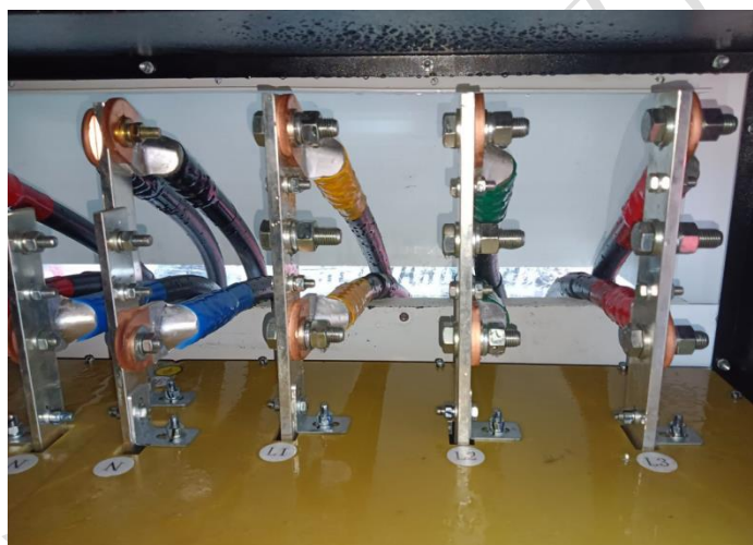
图 6.8 接线盒接线示意图（相间绝缘板未显示）
